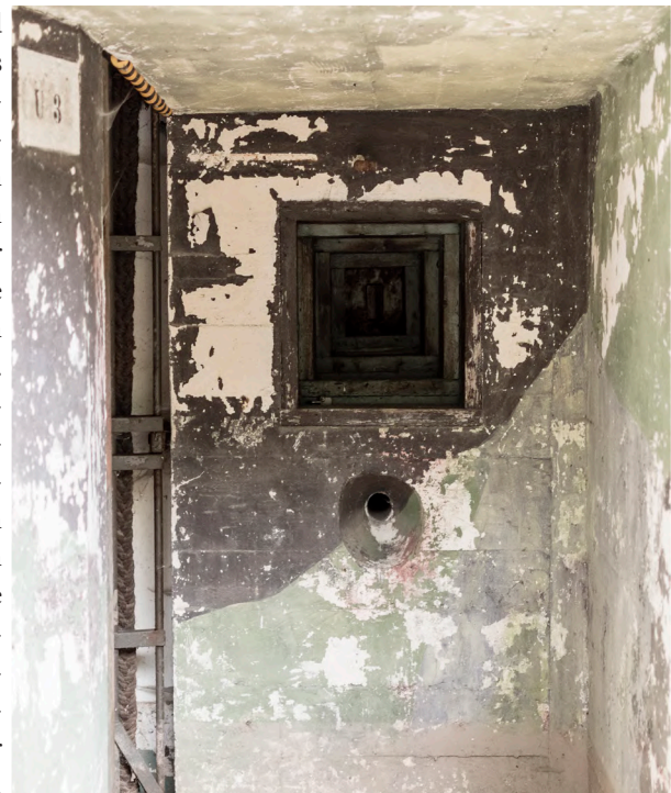
Die Sicherheitsschleuse beim Zugang. Das Loch unter der gepanzerten Luke war für den heißen Empfang. Mit Flammenwerfer.
