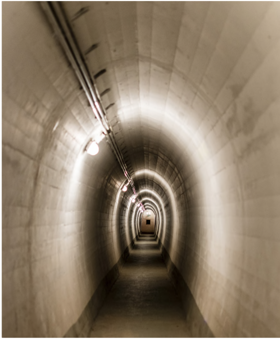
Der 100m lange Zugang in das Herz der Anlage.
