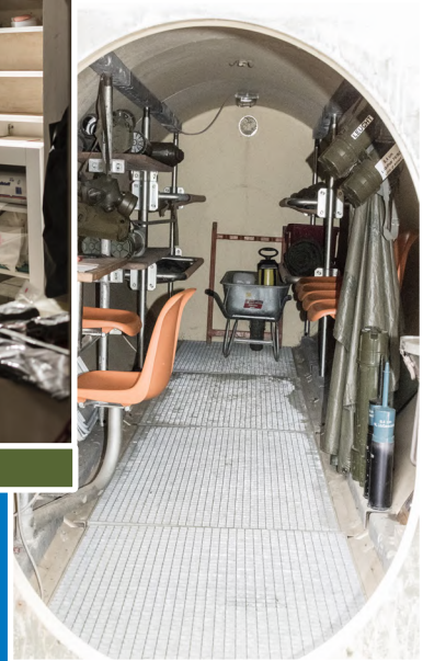
Der Gruppenunterstand einer PAR-Gruppe: Eine Eternit-Röhre, die eingegraben wurde.
